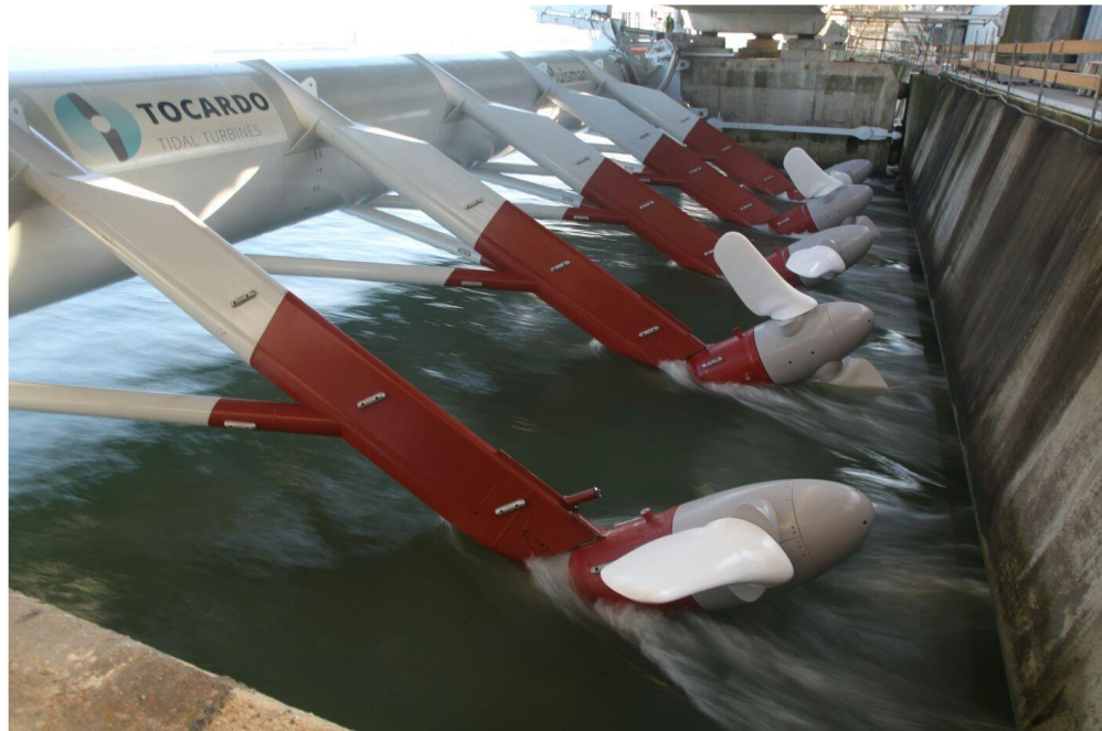
Figuur 7 Tocardo turbines in de Oosterscheldekering. Bron: (TNO, 2018)
